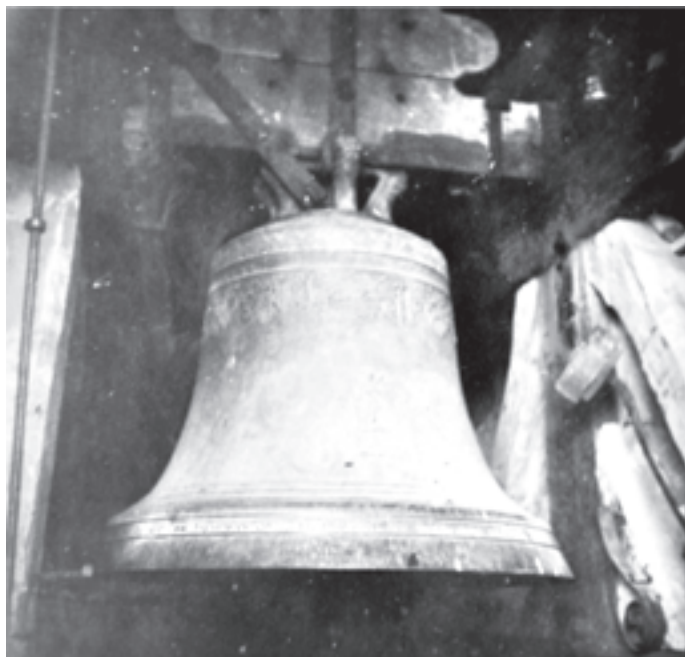
Zvon sv. Jana a Pavla při demontáži 18. 3. 1942. Je to poslední snímek ještě nepoškozeného zvonu, upevňující trmeny nahoře jsou již uvolněné. Vlevo na snímku je patrná hřídel k hodinám, vpravo palice odbíjení hodin.
