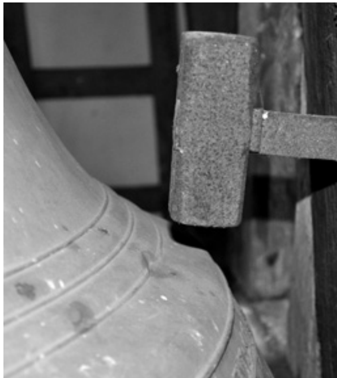
Stará železná palice odbíjení věžních hodin začne po desetiletích spánku a po nezbytné renovaci už zas brzy oznamovat celé hodiny.
